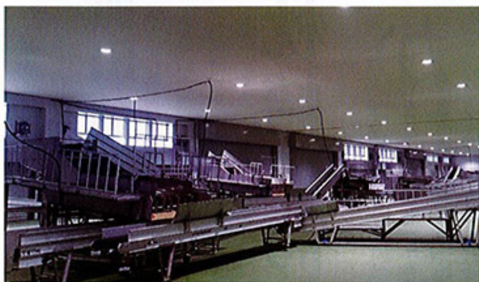
高度衛生管理型荷さばき所の内部
